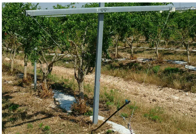
Ancrage palissage de tête avec toron en acier galvanisé 1x7 Ø 3,00 mm
