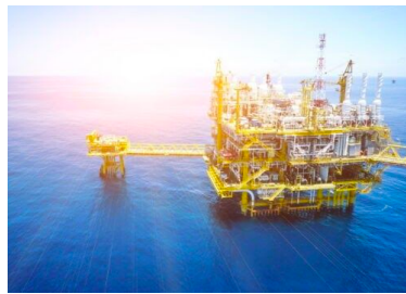
Câbles pour alimenter les plates-formes offshore
