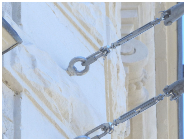
Ancrage du câble de suspension de la Ligne Aérienne de Contact (LAC) de tramways, métros et caténaires légères.
