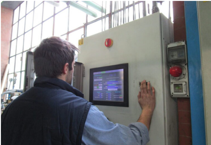
Contrôle informatique du revêtement
