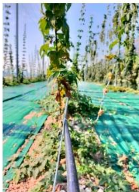
Toron 7 fils Ø 3 mm pour le soutien des conduits d'irrigation
