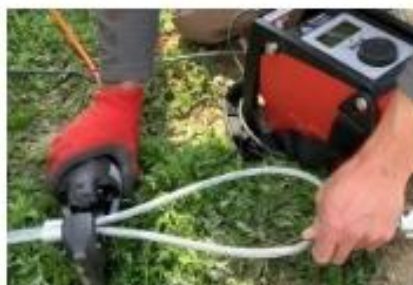
Sertissage des manchons sur le chantier
