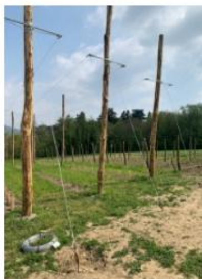
Câbles 133 fils Ø 10 mm pour les ancrages
