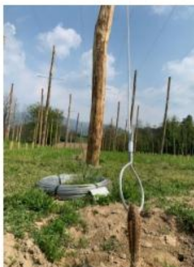
Câbles 133 fils Ø 10 mm pour les ancrages
