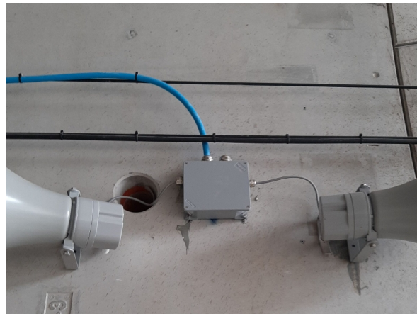
Ancoraggio del cavo portante delle linee di Luce Forza Motrice (LFM) e Telecomunicazioni nelle gallerie. Specifica Rete Ferroviaria Italiana (R.F.I.) FS TT2482.
