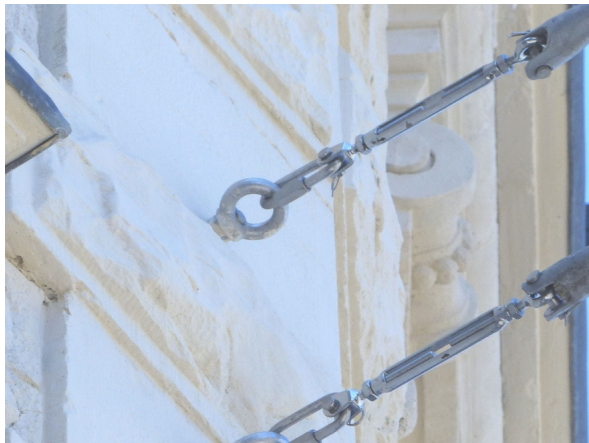
Ancoraggio del cavo portante della Linea Aerea di Contatto (L.A.C.) di metropolitane, tramvie e filobus.
