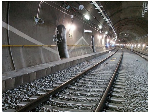
Ancoraggio del cavo portante delle linee di Luce Forza Motrice (LFM) e Telecomunicazioni nelle gallerie. Specifica Rete Ferroviaria Italiana (R.F.I.) FS TT2482.
